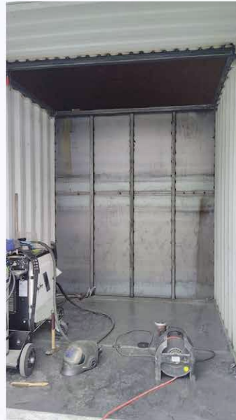
Abbildung 2 und 3 – Anlieferung und Stahlbauarbeiten am Anlagencontainer
